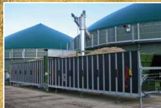
Заправка автоматически дозирующей установки для высоких и низких цистерн.
